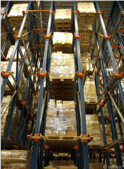
ProStore® koordiniert die gesamte Ein- und Auslagerung.
