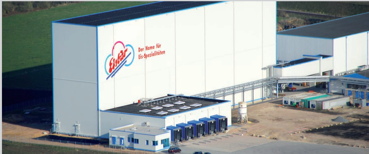
Vollautomatisches Hochregallager mit aktuell 7.000 Palettenstellplätzen
