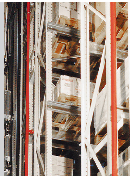
Hochregallager mit 6.800 Stellplätzen
