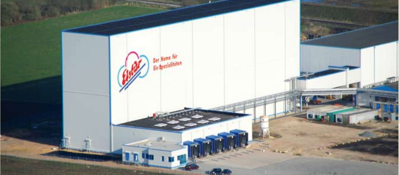
Vollautomatisches Hochregallager mit aktuell 7.000 Palettenstellplätzen
